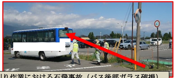
草刈り作業における石飛事故（バス後部ガラス破損）
