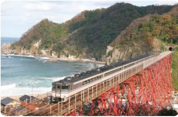
「東洋随一のトレスル式鉄橋」 地上40mの展望台から日本海を一望
