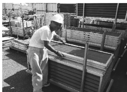
足場材の整備
