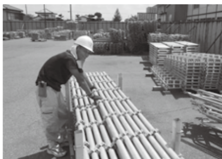
足場材の整備
