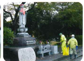
松浦PAでの作業
