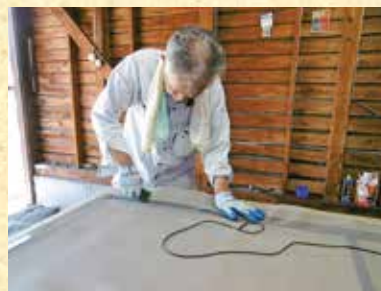
網戸張り替え作業
