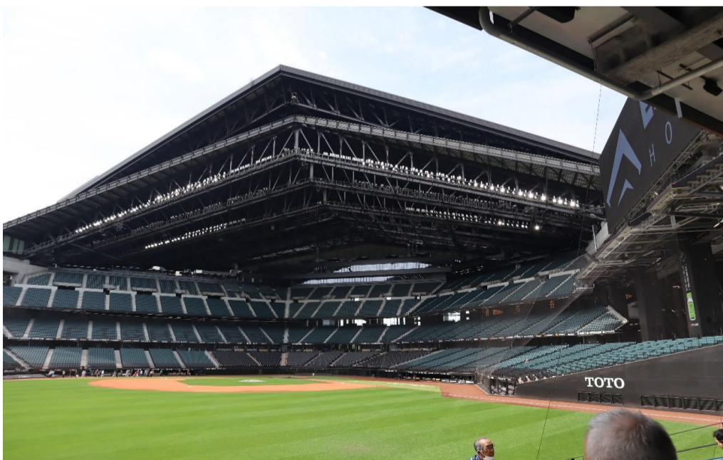
ドームの屋根が解放されていました
