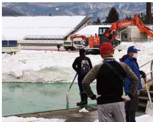
スタジアムの除雪作業
