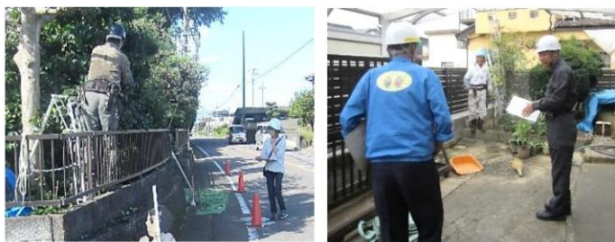
現場パトロールの様子
