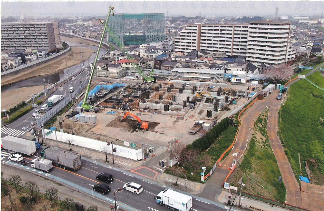
「建設中志木市新庁舎」 提供：志木市
