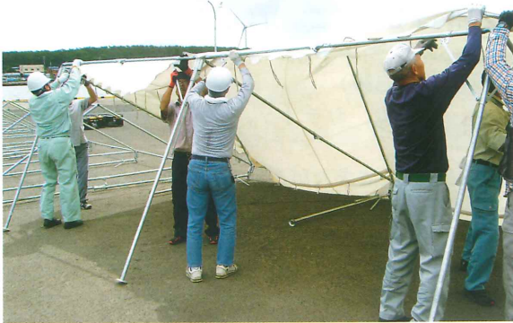
みなと祭りテント設営作業
