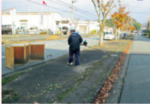
安全を確保しながらの除草作業
