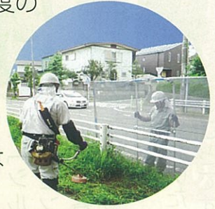
飛散防止用ネットを利用しての草刈作業
