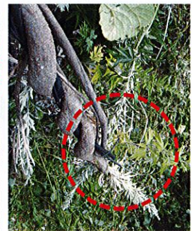
ケーブル切断
