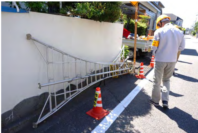
脚立の保管と標識設置
