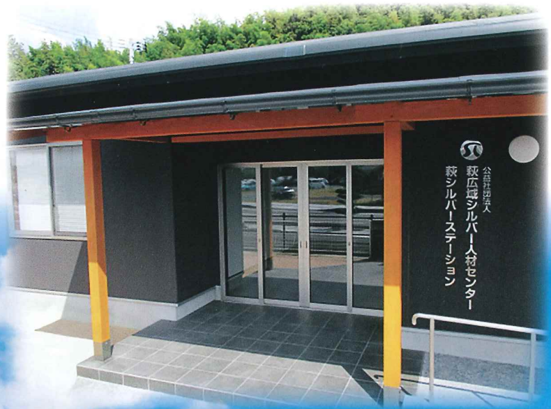
事務所棟玄関
