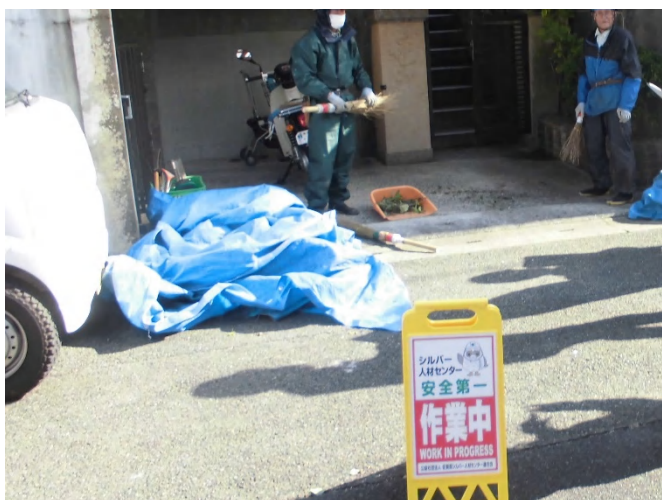
作業中の案内板
