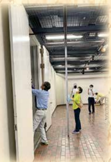
「市民文化のつどい」の撤去作業風景
