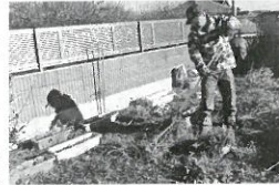
除草後の仕上げ
