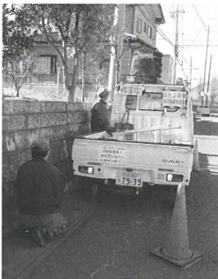
広告除去作業中
