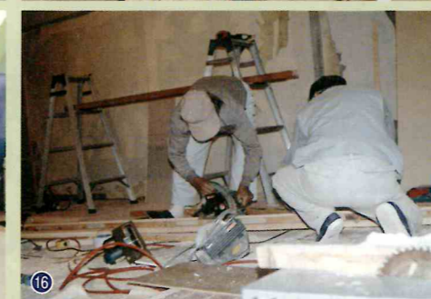
⑮⑯ リフォーム班(クロス張り・大工仕事) ふすま・障子張り・大工仕事、クロス張り・塗装・電気工事等がある
