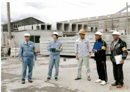
鶴見コンクリート作業現場
