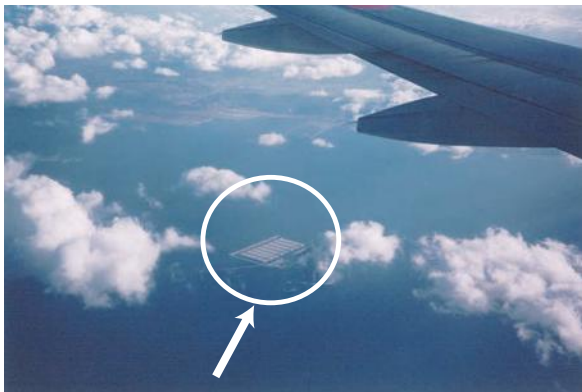
雲間にみえる洋上石油備蓄基地
