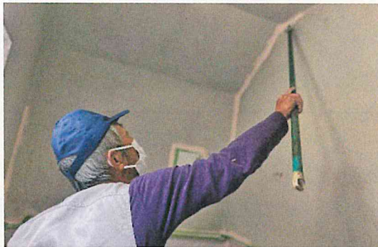
※写真は、風呂場の天井と壁の間を塗装しています。
