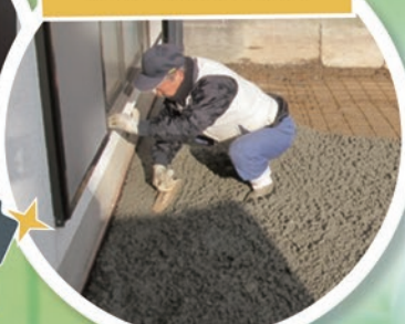
駐車場の整備
