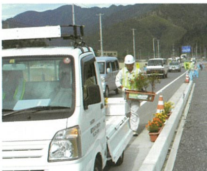
プランター設置
