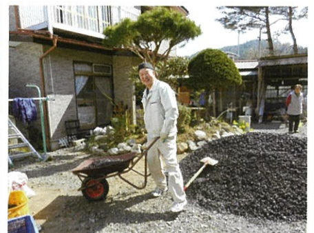
砂利敷き作業
