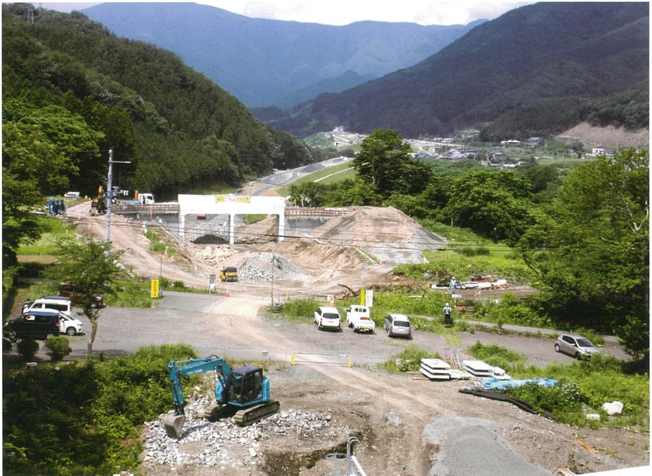
大畑団地より工事中の釜石道を望む
