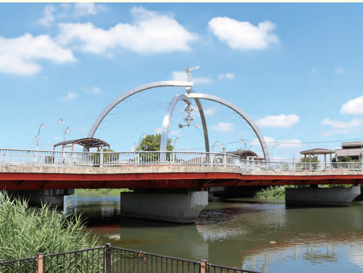
古利根公園橋
