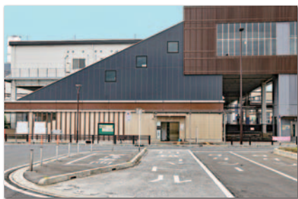
② 新河岸駅舎（東口）
