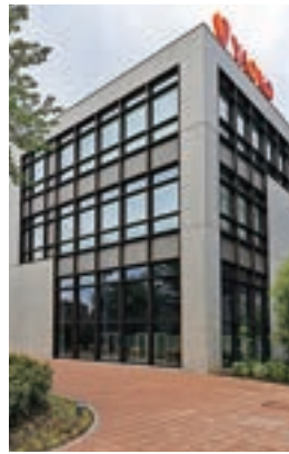
本社 (サポートセンター) 川越駅西口
