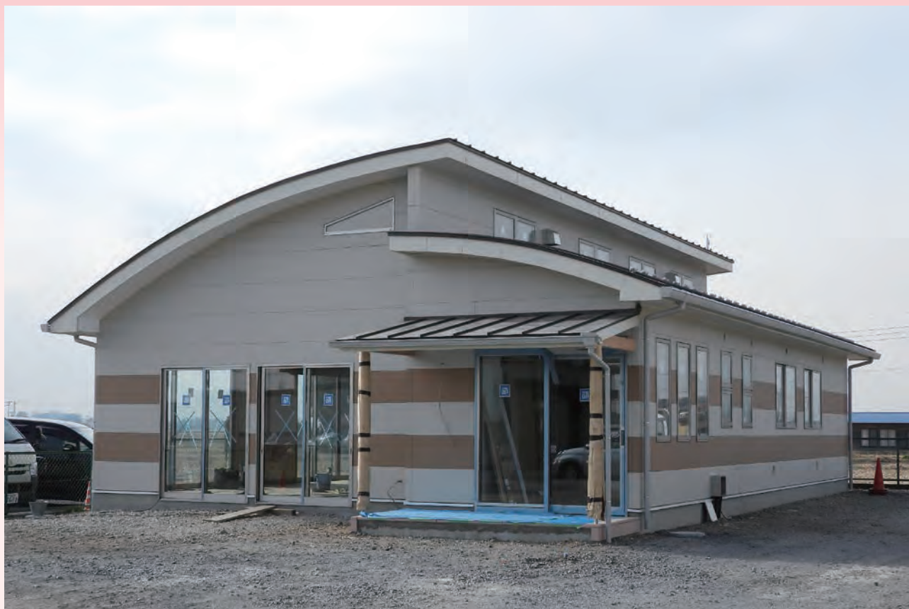
シルバーサロン（平成31年1月31日現在、本部事務所敷地内に建設中）
