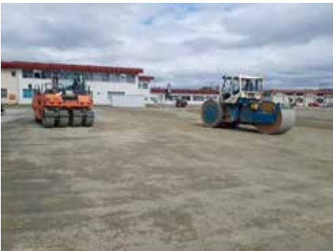
2台のローラーで押し固め
