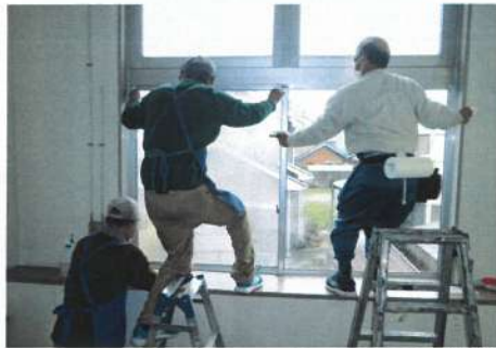
ガラスの飛散防止フィルム張り作業
