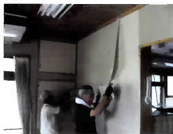
クロス貼替え（蒲生南小学校 学童保育室）
