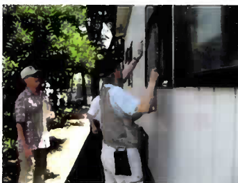
網戸張替え（学童保育室 4 力所）
