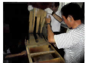
木製ロッカー修繕（大沢北小学校 学童保育室）
