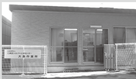
大島作業所外観
