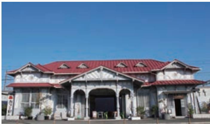
浜寺公園駅旧駅舎 (写真提供：堺観光コンベンション協会)
