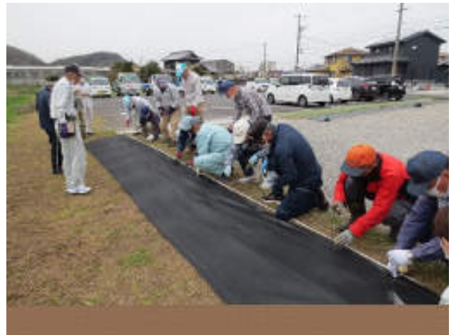
防草シート張り講習
