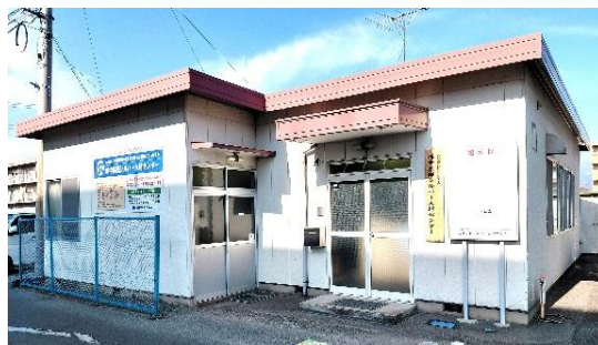
平成4年に建設された事務所
