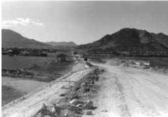
金蔵寺駅北の跨線橋より 鳥坂に続く国道新設工事 (昭和39年2月)
