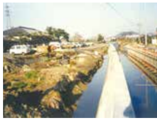
中津万家園前での 県道(さぬき浜街道) の新設工事 (昭和62年3月)
