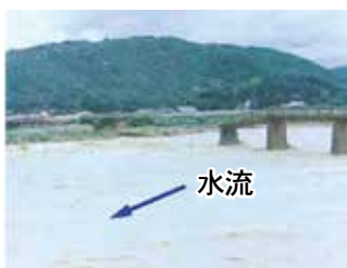
図1 旧乙井橋流失（河口より11.6km付近）（昭和50年8月洪水）
