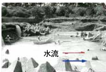
図2 野津床止護床工の洗掘被災（15.4km付近）（平成2年9月洪水）
