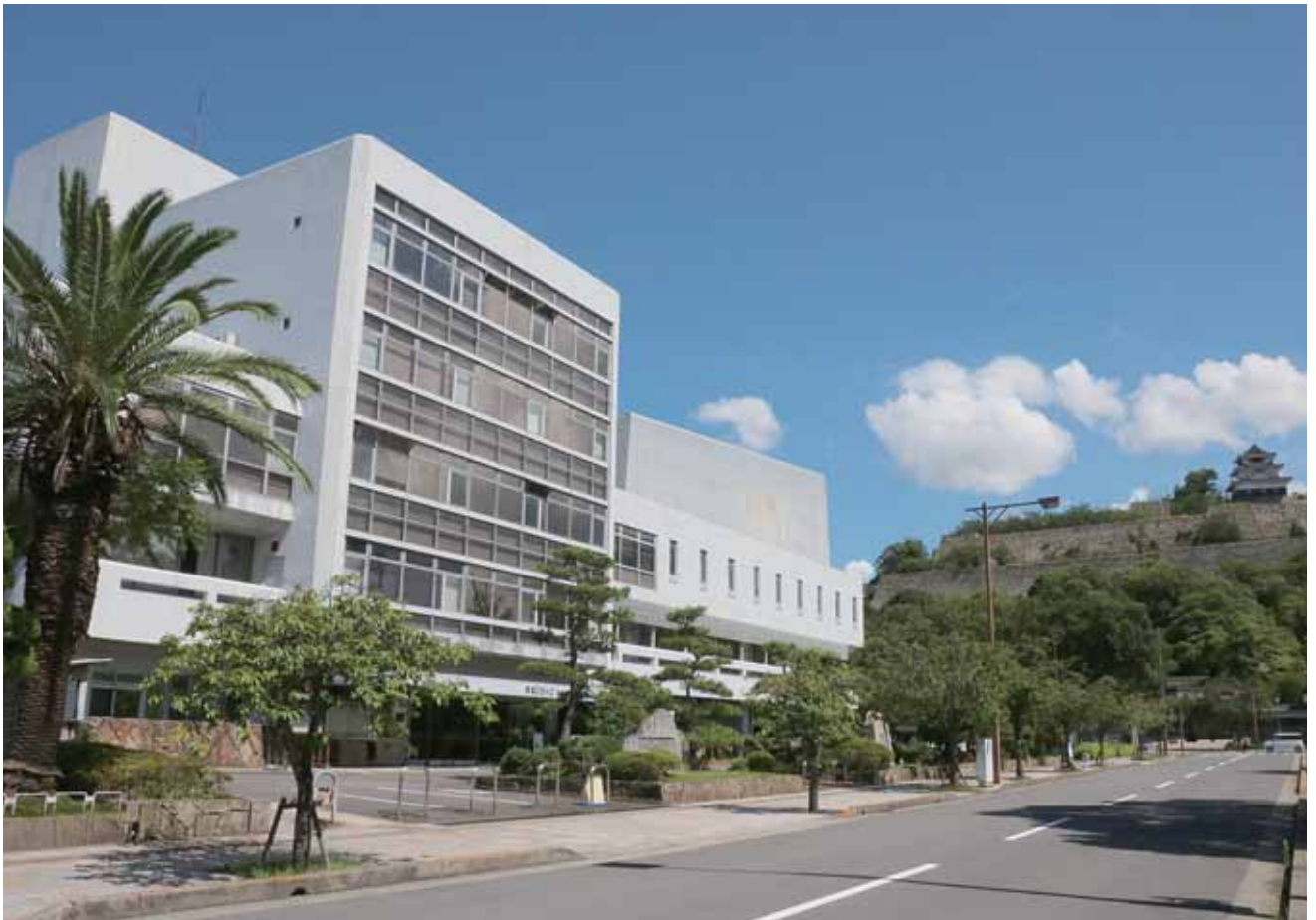
丸亀市生涯学習センター（昭和49年11月「丸亀市総合会館」として開館 平成12年4月「丸亀市生涯学習センター」と名称変更）
