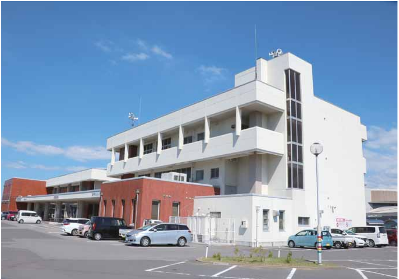
丸亀市綾歌市民総合センター（昭和53年6月 綾歌町役場として竣工。平成17年3月 丸亀市と合併により名称変更。）（写真撮影：川西町・石井誠一） 綾歌図書館・栗熊コミュニティセンターを併設。平成30年9月改修工事完了。
