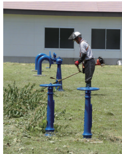
占勝園浄水場では炎天下の作業
