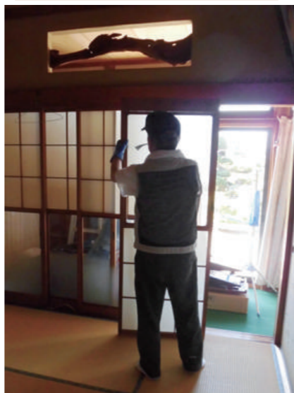
敷居から外した時点でガラスを外す
