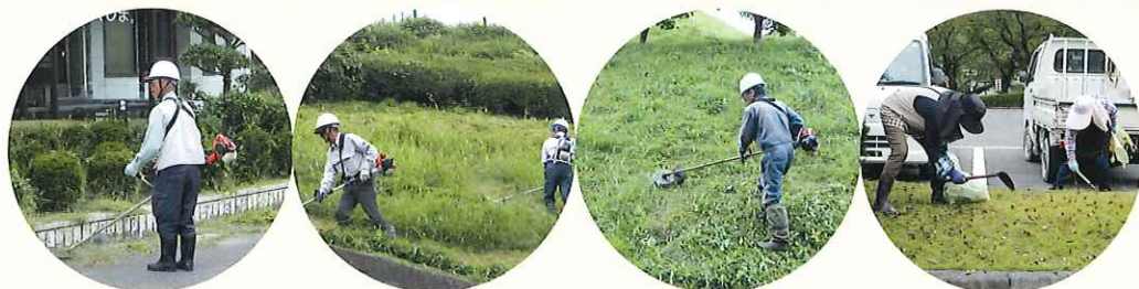
～岩代支所・岩代第2体育館2か所の作業の様子～
