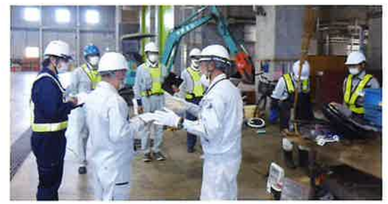
見附市SC 工場内パトロール
