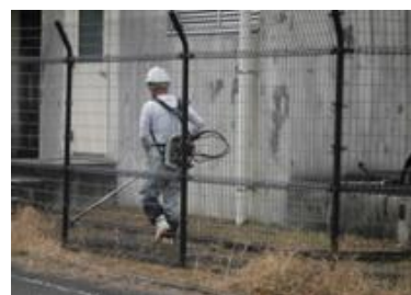
草刈作業（浄水場）
