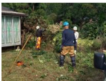
伐採作業（民家）
