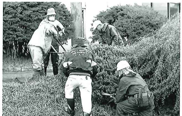
長根山運動公園 作業風景
