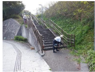
リアスホール駐車場階段
