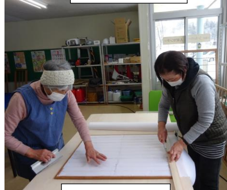
障子貼替作業
