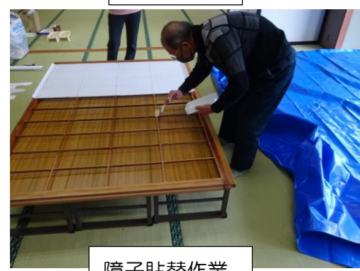
障子貼替作業
