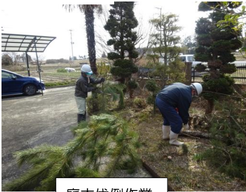
庭木伐倒作業
